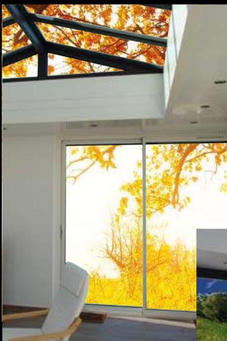
**La véranda à toit plat permet de réaliser des châssis de grande hauteur et de laisser rentrer une plus grande quantité de lumière.**
